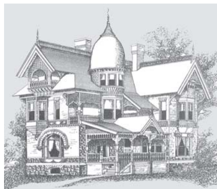
Рис. 10. Дом с башней, покрытой крышей сложной специальной формы
