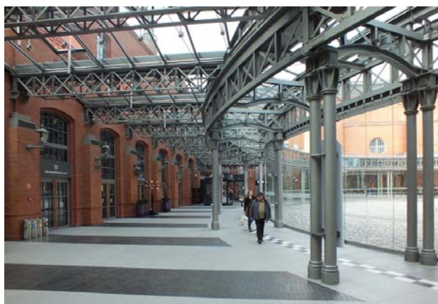
Старый бровар, (промышленное сооружение 1850 г.) Познань, 2002-2005 гг. Архитектурная студия АДС
