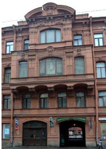
Рис.10. Нижняя часть эркера (Санкт-Петербург)
