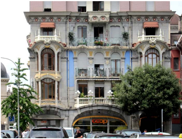
Рис.13. Верхняя терраса эркера (Монрё)
