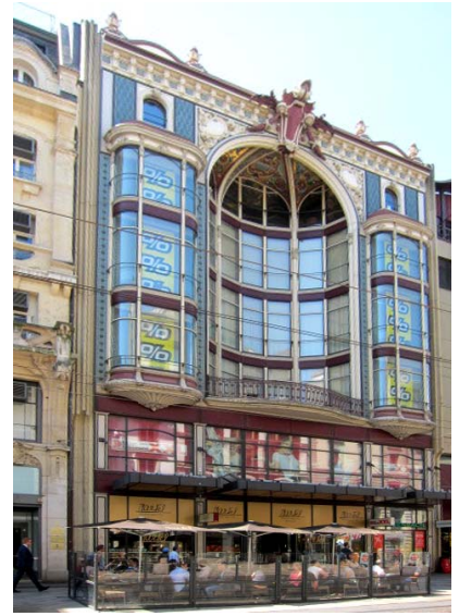
Рис.7. Эркер со светопрозрачными ограждениями (Женева)
