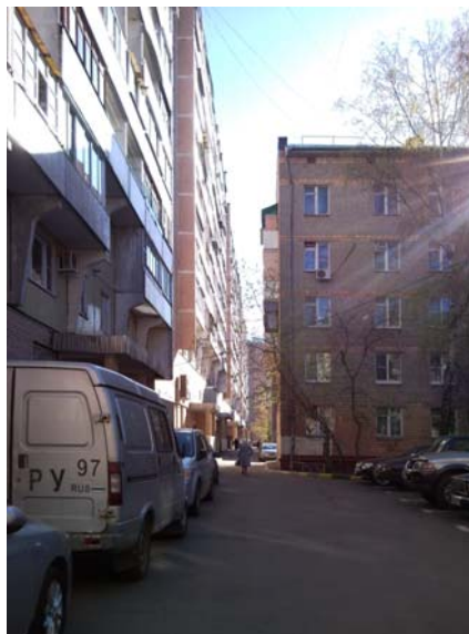
Переуплотнение застройки, вызывающее затенение фасадов, требует перепланировки и расселения квартир
