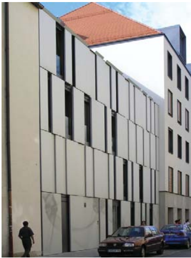
Рис.2. Проектирование в исторической среде (современная застройка в центральной части Мюнхена)
